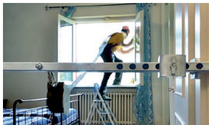
Traversa di sicurezza utilizzabile come punto di ancoraggio per porte o finestre
